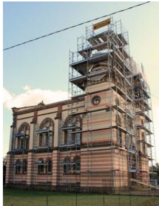
La synagogue de Soultz-sous-Forêts a bénéficié d'importants travaux de restauration l'an passé.
